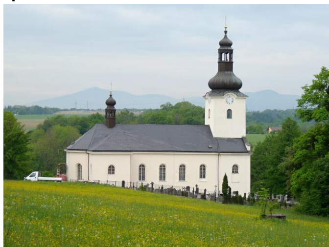
Opravený kostel ... Bruzovský občasník vydal Obecní úřad Bruzovice 16. května 2012.
